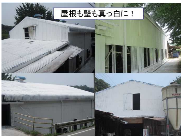
写真 1 ドロマイト石灰乳で屋根・壁を真っ白に塗布した事例（兵庫県）
