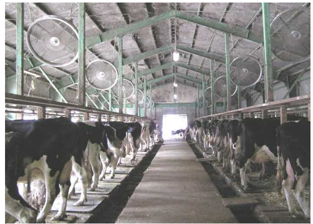
写真 2 送風ファンは斜め下向き一方向に設置する！（兵庫県）
